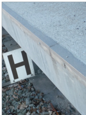
▲ Und auch an Bahnsteigkanten einsetzbar.
