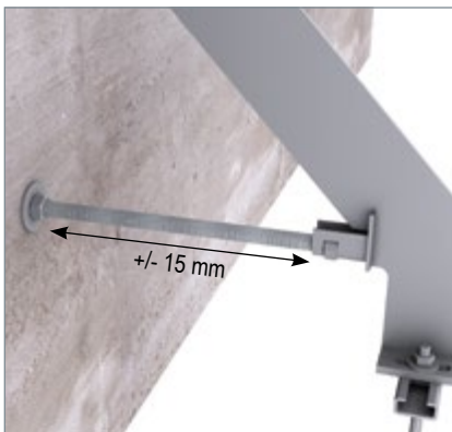
▲ ... Druckschraube justieren, bis diese am Rohbau kraftschlüssig anliegt
