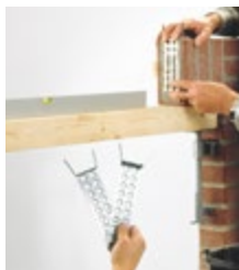
▲ ... während des Mauerns auf den Stein aufhängen...
