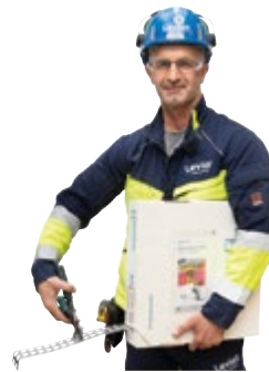
▲ ... und mit einer Blechschere abschneiden
