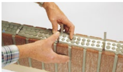
▲ ...und nach Fertigstellung der Grenadierschicht das MOSO® Lochband zwischen die Bügel auflegen. Danach werden die Lochbandbügel einfach zugebogen. Fertig.
