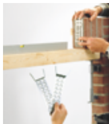
▲ ... während des Mauerns auf den Stein aufhängen...
