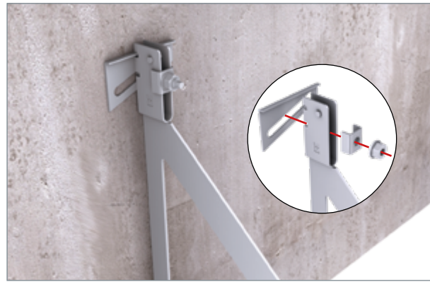
▲ ... gekröpfte U-Scheibe aufsetzen und mittels Sechskantmutter SKM handfest vormontieren...
